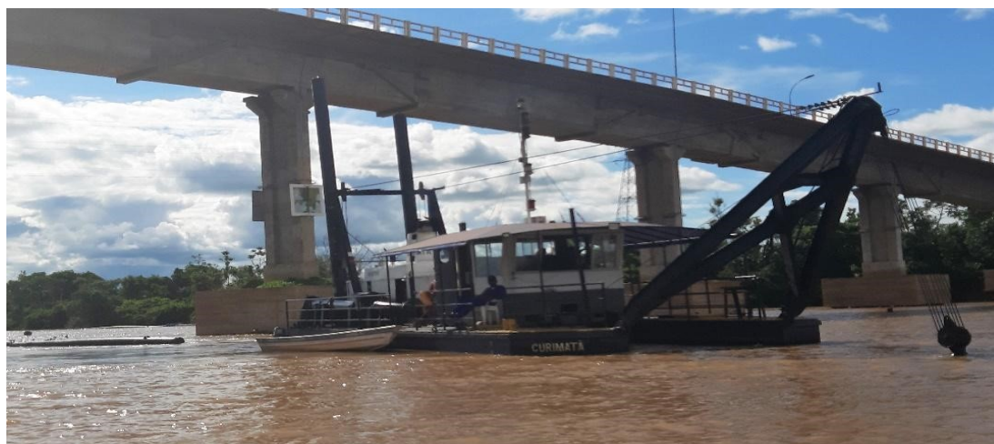
Fotografia 40 - Drega efetuando remoção de sedimentos do rio Paraguaí (MT)
